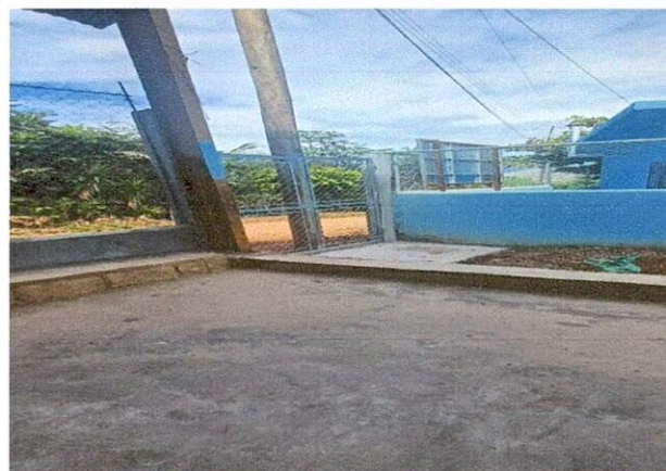
Foto 4: Mejoramiento en entrada principal del Instituto e instalación de portón.
