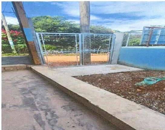
Foto1: Mejoramiento en entrada principal del Instituto e instalación de portón.
