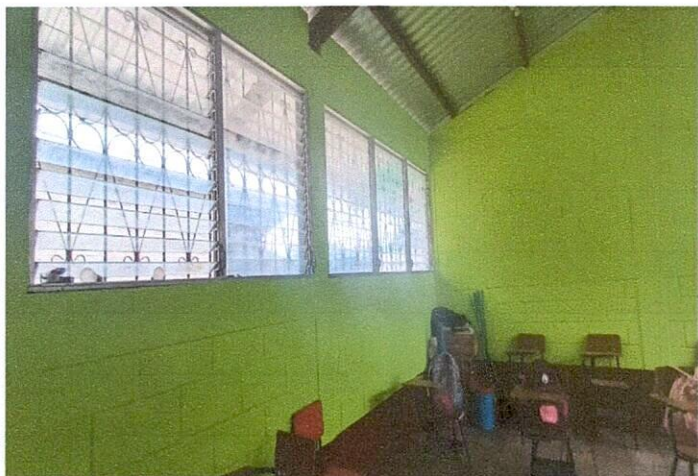
Foto 3: Mejoramiento de pintura en el interior del Instituto.
